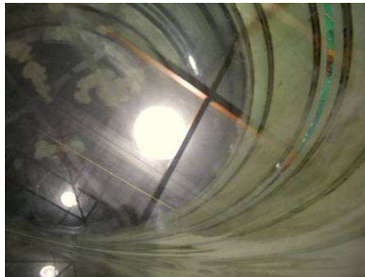
(b) 清洗封盖后俯视桶内
