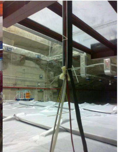
图 5.6 望远镜模块的高压电缆
